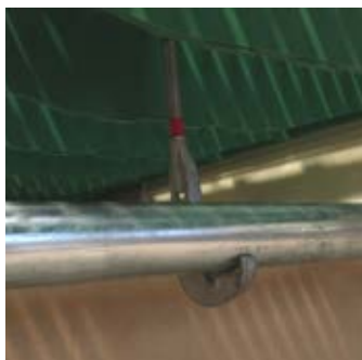
Montage de l'ancrage en J - Articles N° 30847 et 90130847
